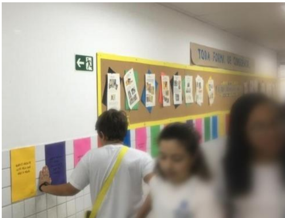
Figura 21: Aplicação de faixa horizontal de cortiça em parede, CPII, Campus Humaitá I
